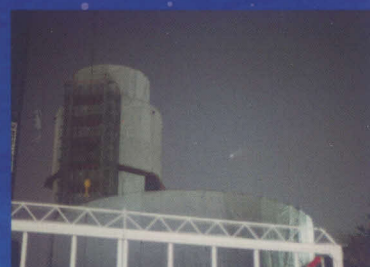
1997年 震災復旧工事中の 天文科学館とヘール・ボップ彗星
